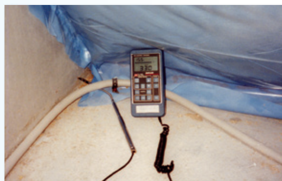
Localisation de fuites avec anémomètre
