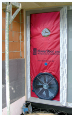
Mesurage BlowerDoor d'une maison individuelle nouvellement construite
