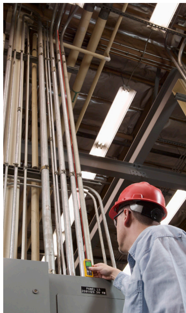
Mesure de la hauteur d'un plafond surélevé.
