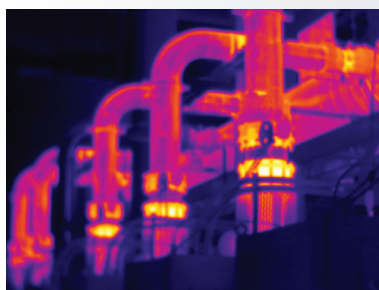
Mise au point manuelle
