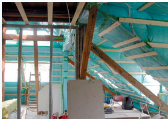
Le niveau étanche (film et panneaux bois) est encore visible. C'est le moment idéal pour un test BlowerDoor.
